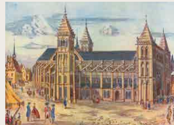
◆ La collégiale avant sa démolition. On aperçoit la Tour Charlemagne au premier plan à gauche.
