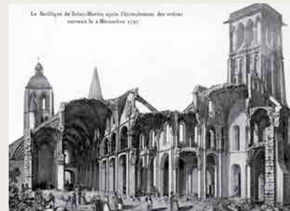
◆ Vue de la collégiale Saint-Martin après l'effondrement des voûtes survenu le 2 novembre 1797.
