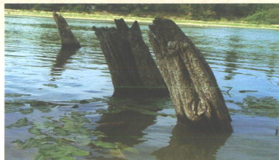
Fig. 5 : Pieux inclinés à l'amont de la palée sud du pont 1. Vue du sud.
