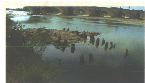
Fig. 4 : La palée sud du pont 1. Vue du sud-est.
