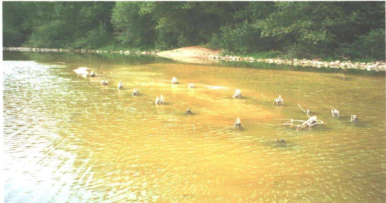
Fig. 8 : Pieux d'une des palées du pont 2 proches de l'île Aucard. Vue du sud-ouest.
