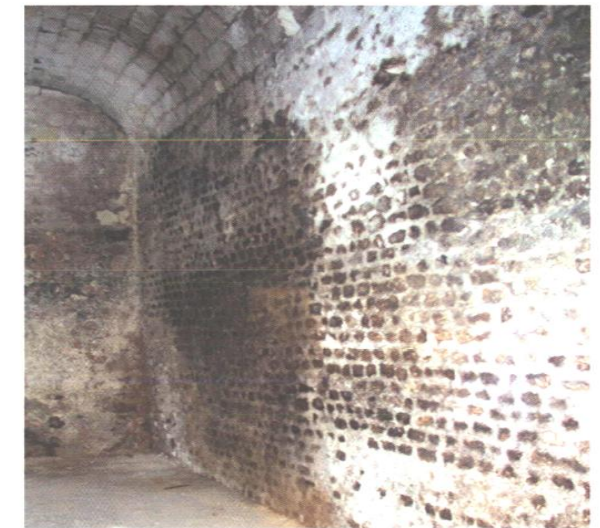
Fig. 7 : Parement extérieur de l'amphithéâtre originel (cave du 7 rue de la Bazoche).
