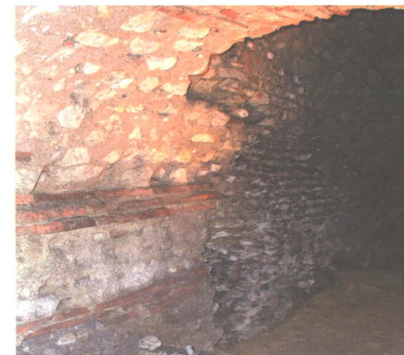
Fig. 9 : Vomitoire sud-est, jonction entre l'amphithéâtre agrandi (au premier plan) et l'amphithéâtre originel (cave du 4bis rue Manceau).
